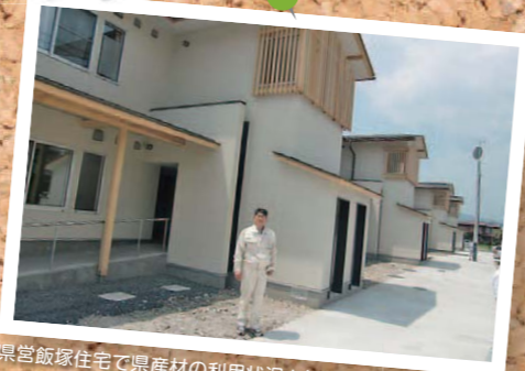
県営飯塚住宅で県産材の利用状況を視察する
