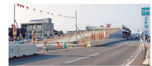
国道13号大野目交差点立体化の工事状況
