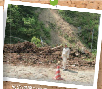
米沢南陽白鷹線の土砂災害の状況と復旧計画の説明を受ける
