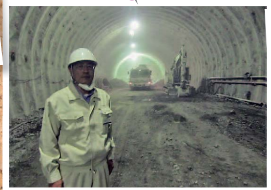
東北中央自動車道栗子トンネル工事の進捗状況の視察
